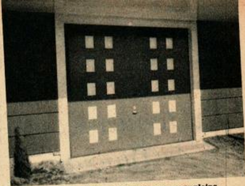
Le motif est constitué ici par des petits panneaux pleins formés de planches sciées. Le bord des rectangles est chanfreiné pour donner un aspect plus soigné.
