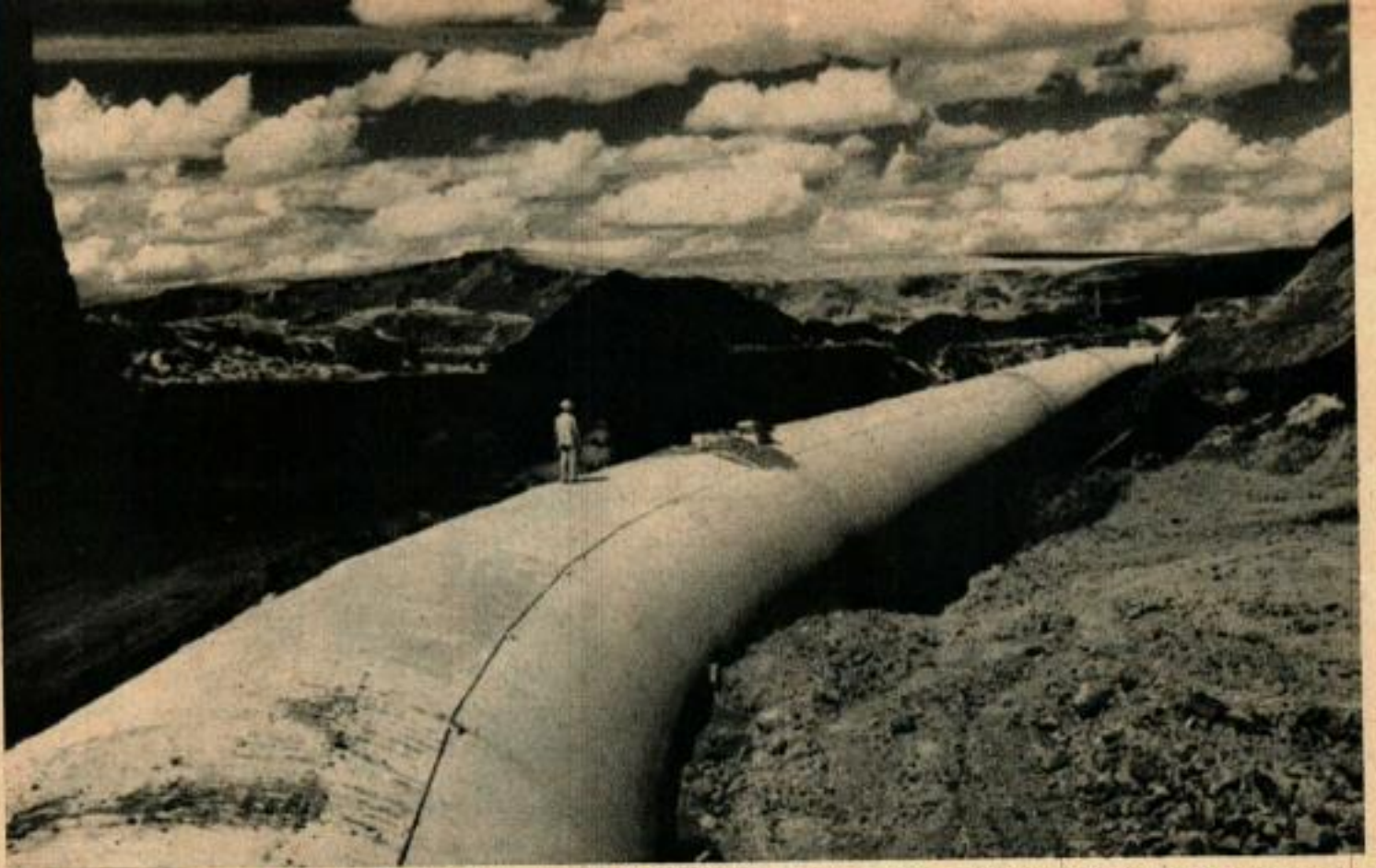
Le plan d'irrigation du District de Columbia, à Washington, utilise une conduite géante de 8 mètres de diamètre. Ci-dessous, le vaste gisement de minéral de fer de Mesabi.
