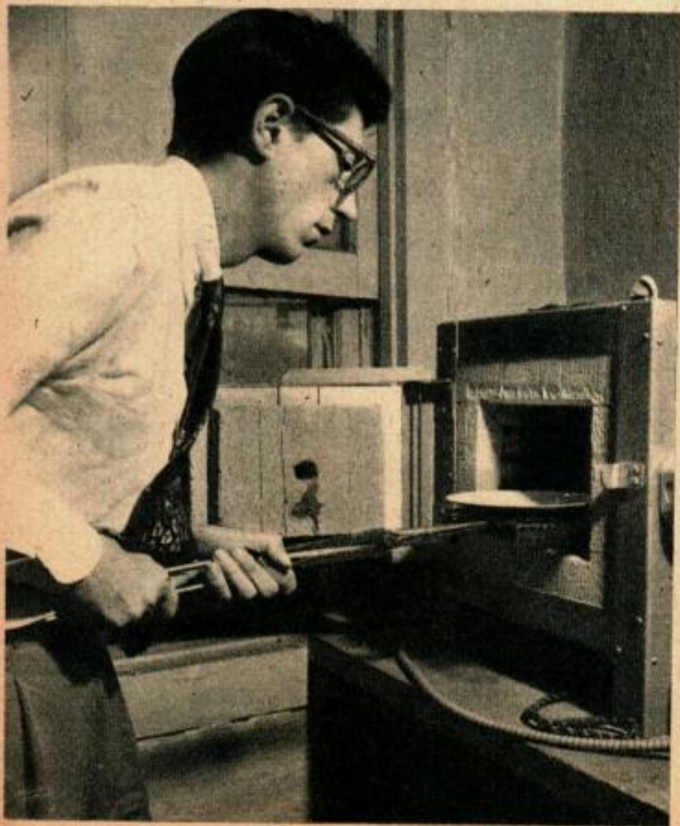
Ci-dessous, mise au four au moyen d'une pince très longue. C'est avec cette pince qu'on manie le plat pendant qu'il est chaud. Poser la pièce à émailler sur une grille en nickel-chrome pour en faciliter la manutention.
