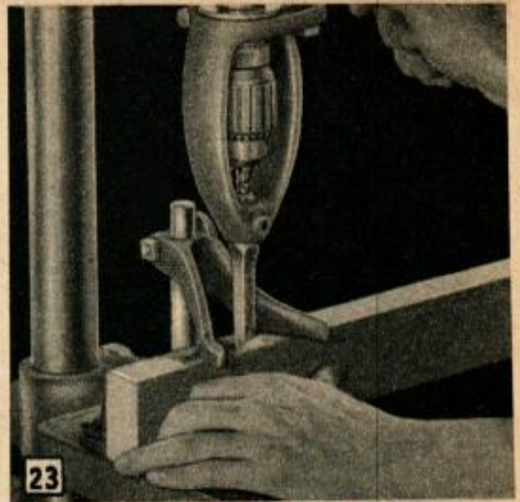
Transformation en mortaiseuse à mèche.
