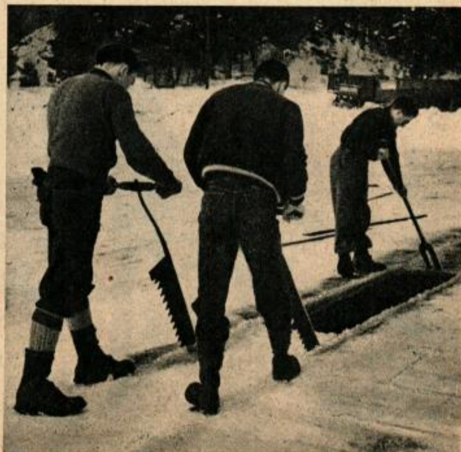
Les blocs-clés, que l'on doit enlever tout d'abord, doivent être détachés à la main; le reste l'est au burin.
