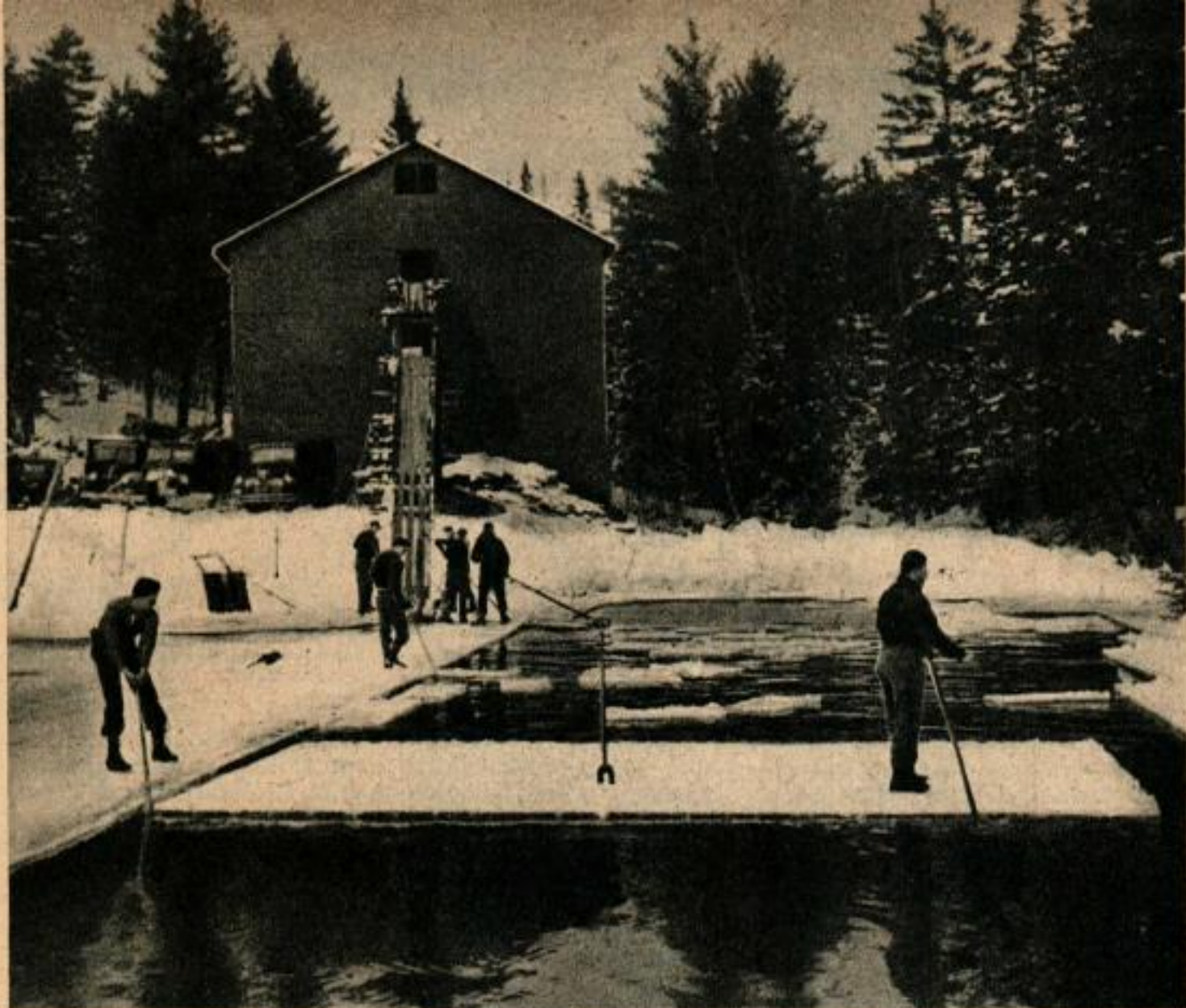
On amène la glace par flottage jusqu'à l'embarcadere, en grands morceaux que l'on brise en blocs avant de les faire monter sur le toboggan.
