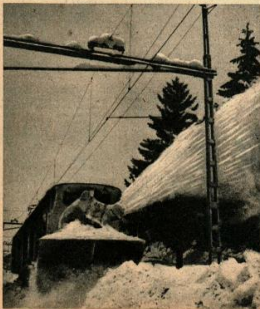
Ce chasse-neige original est monté sur une plaque tournante, qui, à son tour, est montée sur un wagon. Il n'est pas nécessaire de disposer d'un embranchement de voie pour renverser la machine: deux hommes suffisent à faire tourner l'engin sur place.
