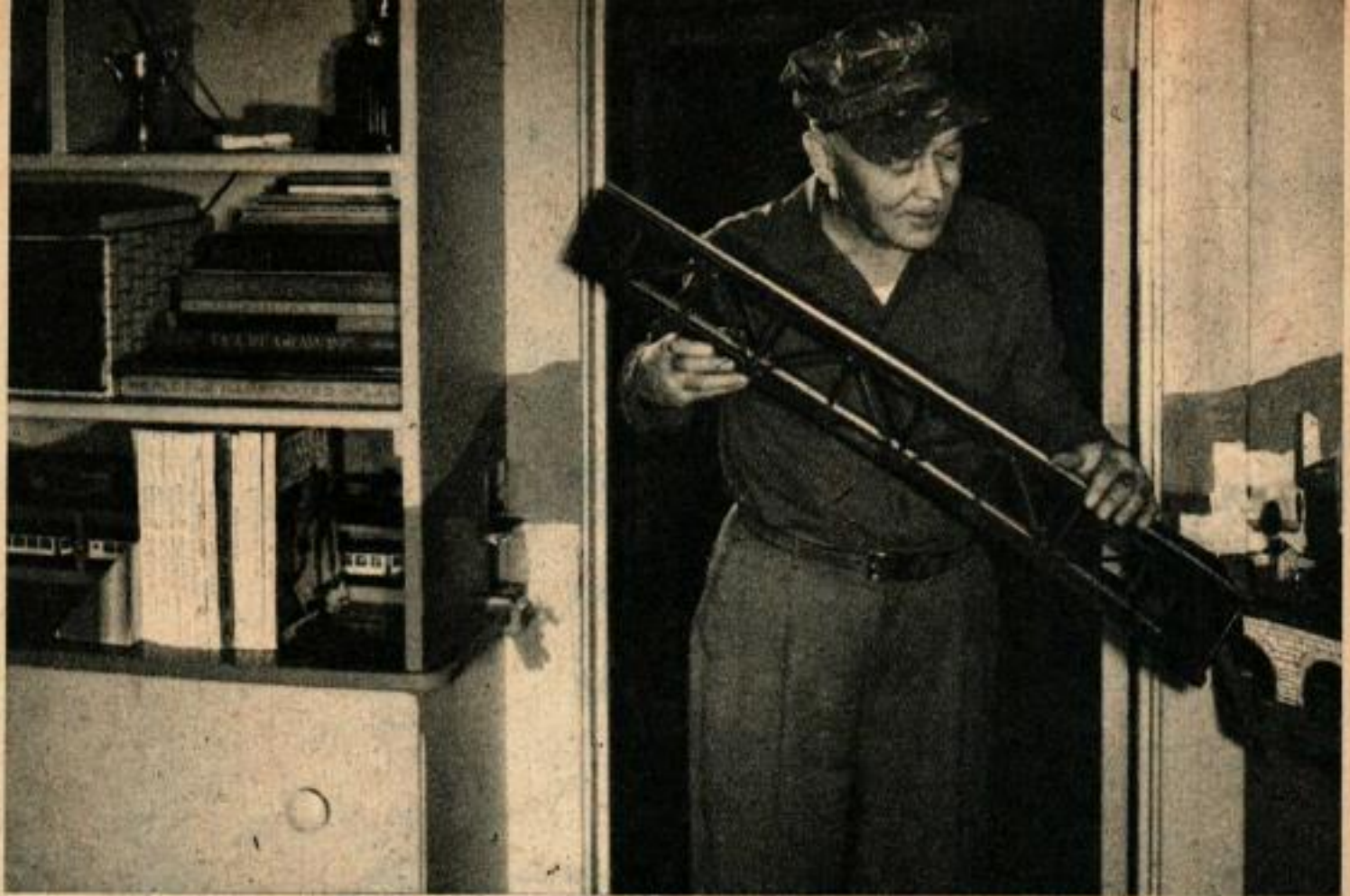
Le pont-levis enjambe la largeur de la porte: on le relève quand on ne s'en sert pas. Un montage précis évite des déraillements désastreux.
