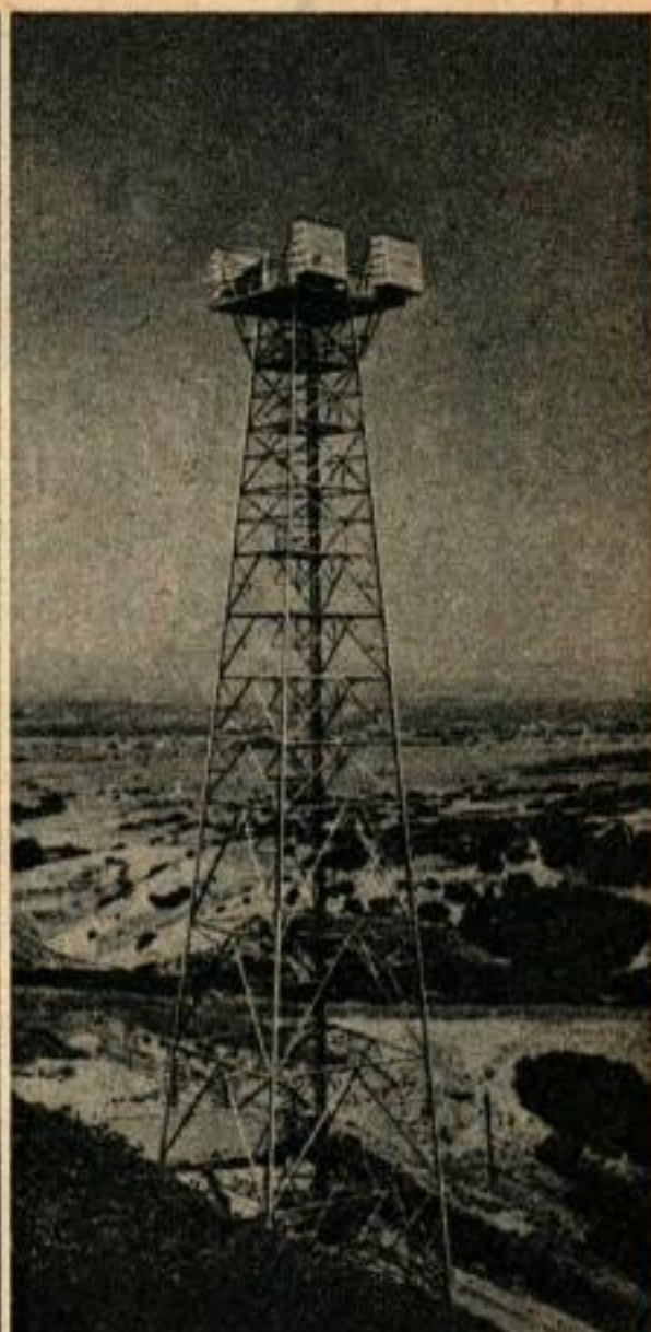
Les dessins montrent les installations typiques d'un pylône de relais transcontinental. Ci-dessus, à droite, le pylône de 60 m dominant Salt-Lake-City est l'une des 105 stations.
