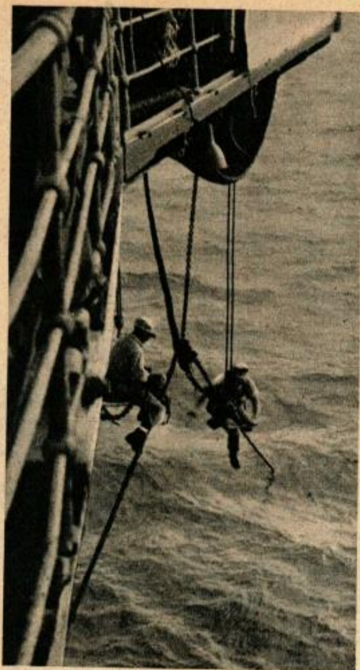
Une autre méthode possible pour transmettre la télévision à travers l'océan, consistant à utiliser un câble, comme ce câble amplificateur téléphonique.
