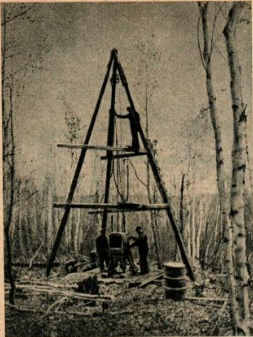
Avec ces engins, les mineurs font des sondages dans tout le massif pour connaître l'étendue du gisement de taconite.
