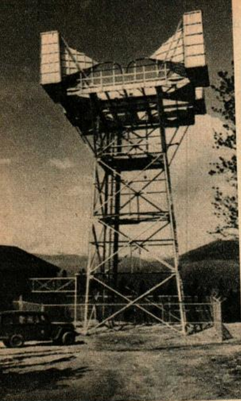
Le pylône de relais à ondes ultra-courtes peut véhiculer simultanément plusieurs communications dans chaque sens.
