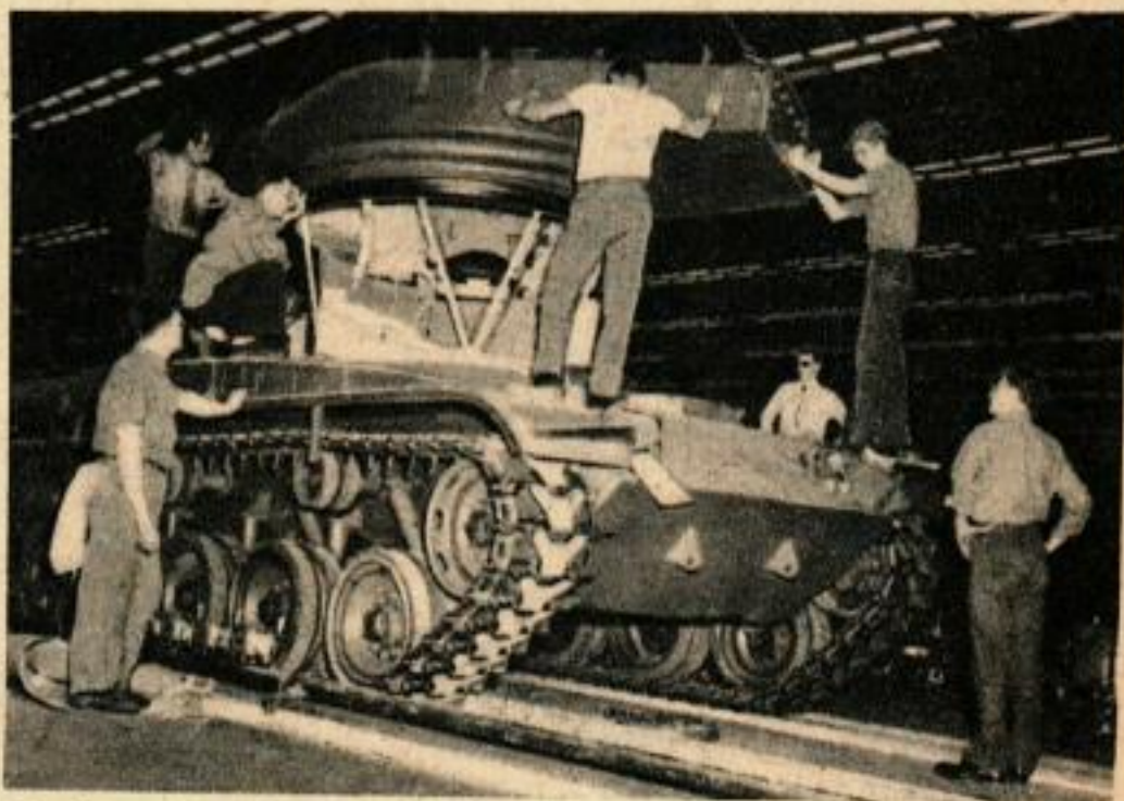
On descend la tourelle de son «panier» sur la partie inférieure du tank. Un bon producteur de tanks de la deuxième guerre mondiale, Cadillac, réalise le T-41 dans son usine située à la lisière de Cleveland. Ci-dessous, la boue, les crevasses profondes, les pentes raides ou le sable ne peuvent que ralentir le Bulldog de 23 tonnes.
