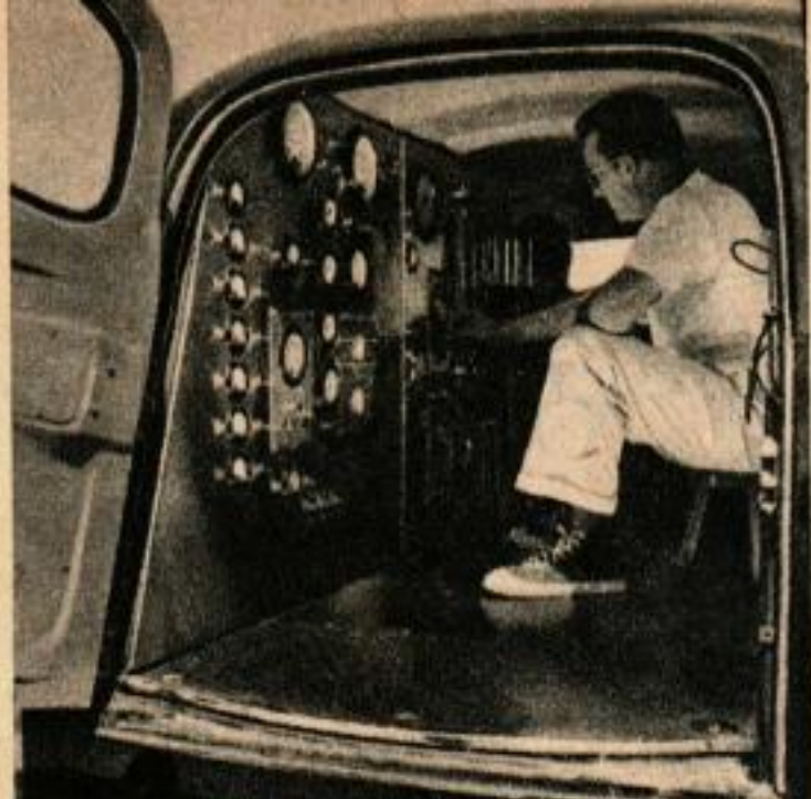
Garni d'un arsenal impressionnant de cadrans et d'interrupteurs, l'intérieur du camion est un laboratoire sur roues fort efficace.
