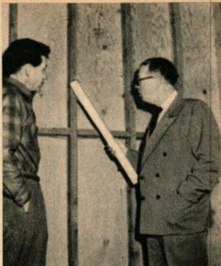
Voici l'architecte en conférence avec Tom Riley et lui expliquant la construction préfabriquée dont il est l'auteur. Les murs sont exécutés séparément et montés afin d'être vérifiés avant d'être transportés sur l'emplacement de la maison. L'on économise ainsi un temps précieux et l'on peut achever la couverture de la maison en un temps record.
