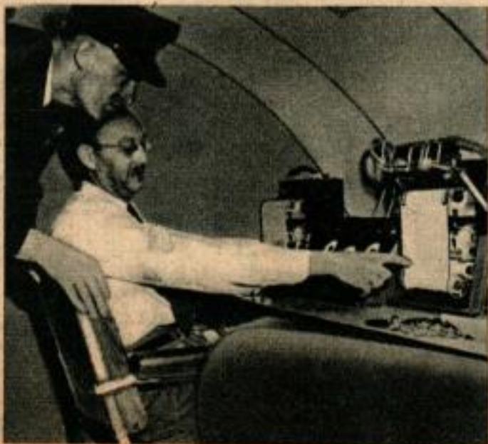
Le savant et le pilote vérifient l'appareil enregistreur qui détecte de l'avion la présence du minéral. Ci-dessous, à droite, le magnétomètre est monté sous la queue de l'avion amphibie.
