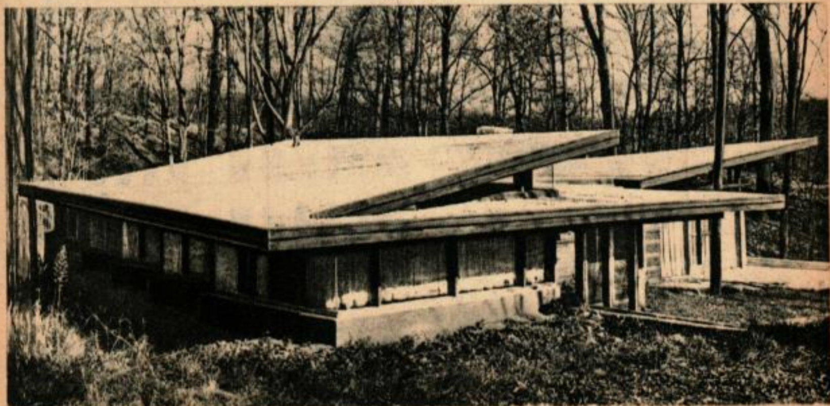
Certains toits sont si bas que les enfants peuvent y jouer. Les fondations sont inspirées par des techniques nouvelles.
