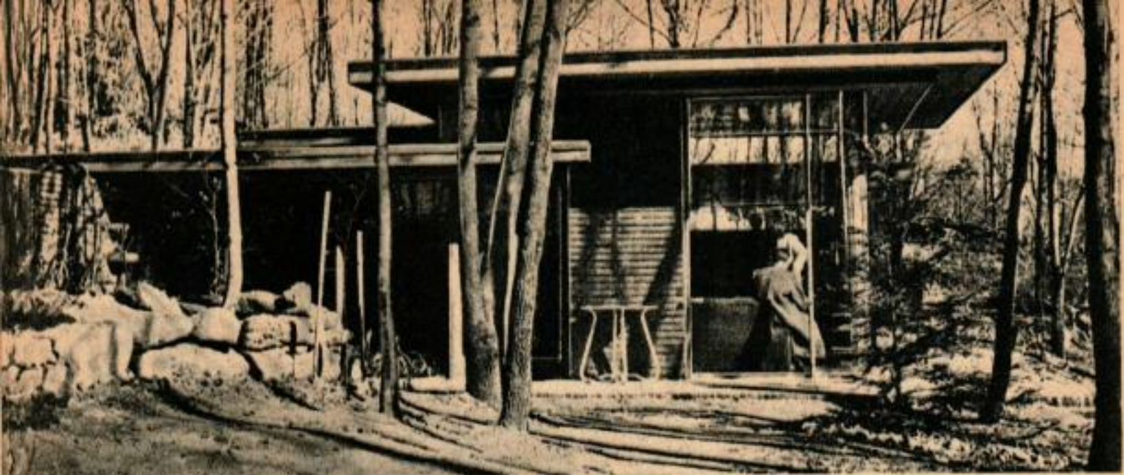
Deux parois entières de l'appartement sont en verre. L'auvent laisse passer les rayons solaires en hiver, mais non en été.
