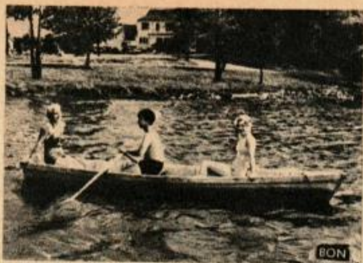
La photo de gauche montre une bonne répartition du poids à l'intérieur du bateau, ce qui assure une vitesse maximum et un pilotage sûr et efficace. Les charges placées trop vers l'avant rendent pénible le maniement des rames. En outre, le bateau risque d'embarquer de l'eau par l'avant.
