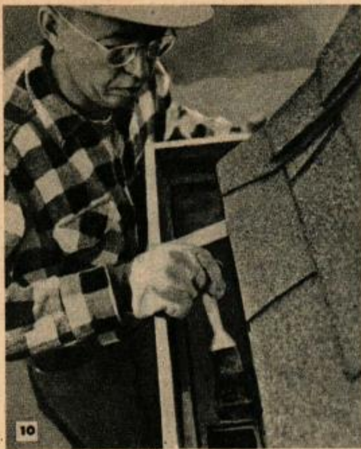
Les gouttières métalliques de tous genres doivent être protégées par l'application d'un enduit à base d'asphalte. Nettoyer très complètement le métal et passer le mastic visqueux au pinceau.
