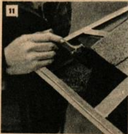
Les petites déchirures du métal se bouchent au moyen d'une pièce d'étoffe. Mettre du mastic avec un pinceau, comme dans la figure 11, poser une pièce d'étoffe (fig. 12) et bien enduire le tout d'une couche épaisse de mastic.
