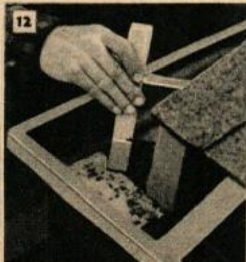
Les petites déchirures du métal se bouchent au moyen d'une pièce d'étoffe. Mettre du mastic avec un pinceau, comme dans la figure 11, poser une pièce d'étoffe (fig. 12) et bien enduire le tout d'une couche épaisse de mastic.
