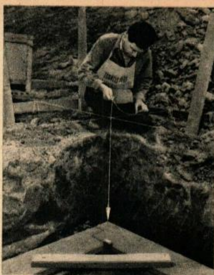
Ci-dessus, première étape après le coulage des semelles de béton. Je suis en train de vérifier l'angle où s'assemblent les planches sur lesquelles on vient ensuite poser le coffrage pour le béton. Ci-dessous, mon aide et moi, montons le boisage pour couler les murs enterrés servant de fondations, ces formes sont en contreplaqué de 16 mm.
