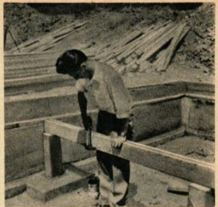
Chaque poutre sur laquelle reposent les solives du plancher est obtenue par clouage de 2 planches de 50 \times 150 . Comme on le voit sur le plan général du plancher, il a 2 poutres de ce genre en prolongement qui s'appuient au centre sur une poutre carrée de 150 \times 150 .
