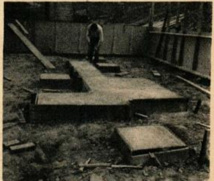
En même temps que les semelles des fondations, on coule les flots du foyer et du mur qui ont 30 cm d'épaisseur. Ci-dessous, mon collaborateur est en train de clouer les solives.
