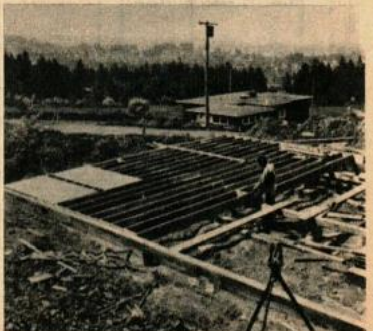
En même temps que les semelles des fondations, on coule les flots du foyer et du mur qui ont 30 cm d'épaisseur. Ci-dessous, mon collaborateur est en train de clouer les solives.
