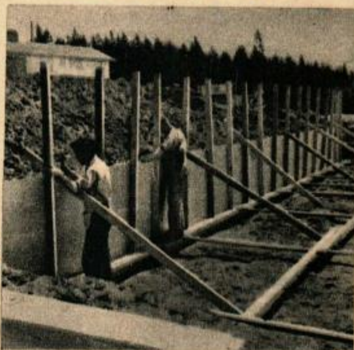
Ci-dessus, première étape après le coulage des semelles de béton. Je suis en train de vérifier l'angle où s'assemblent les planches sur lesquelles on vient ensuite poser le coffrage pour le béton. Ci-dessous, mon aide et moi, montons le boisage pour couler les murs enterrés servant de fondations, ces formes sont en contreplaqué de 16 mm.
