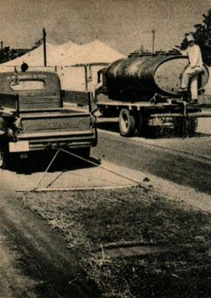
Des morceaux de vieux grillage servent à égaliser la piste. L'arroseuse a été confectionnée avec un camion citerne de rebut.
