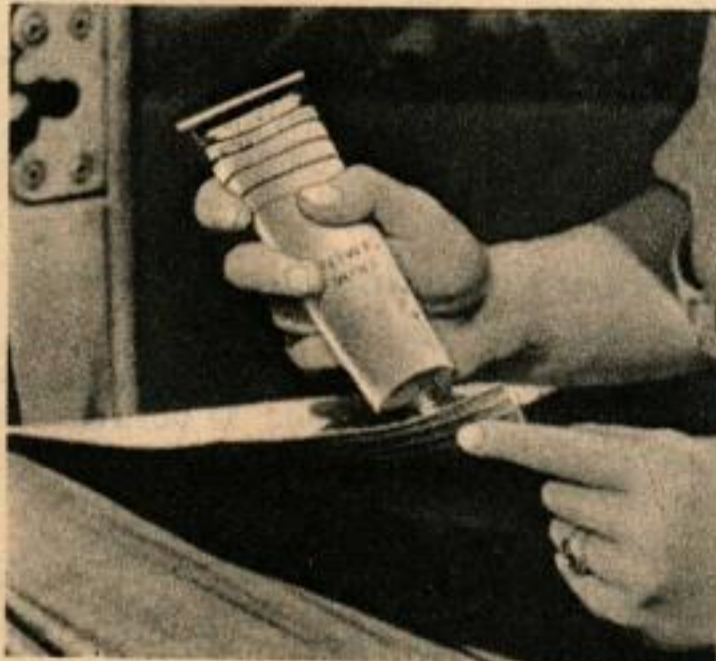
Les tapis de caoutchouc sont réparés par rapiéçage, les pièces étant collées à la dissolution de caoutchouc.
