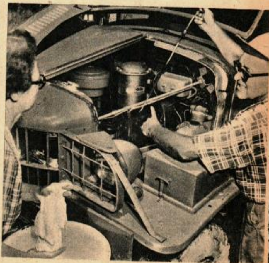
Le levier de commande des roues avant fut déplacé ainsi que deux autres leviers, afin qu'ils soient tous à portée de la main du conducteur. Ci-dessous: un dispositif de raffinage d'huile fut ajouté.
