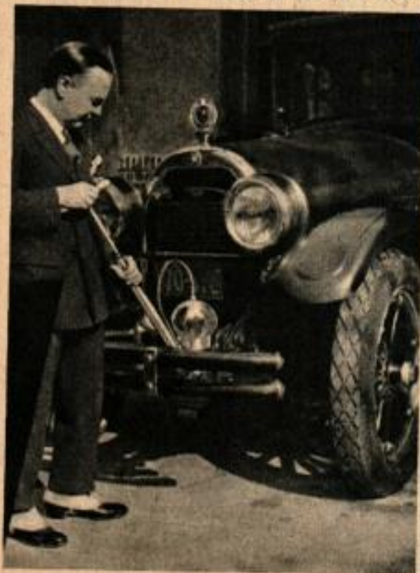
Josef Hofmann, célèbre pianiste, présente, à gauche, un absorbeur de chocs pour voitures fonctionnant à l'air comprimé et, à droite, un nouveau système de touche pour pianos.
