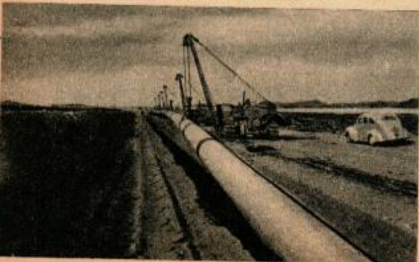
A la station de pompage, une batterie de compresseurs rétablit la pression du gaz, pour compenser les effets du frottement dans les tuyaux. Ci-dessous, des grues sur chenilles, fonctionnant par groupe, descendent doucement dans la tranchée les tuyaux soudés et enveloppés.
