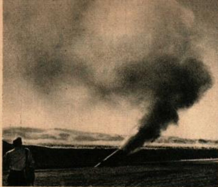
Le nouveau pipe-line est débarrassé des poussières et autres corps étrangers au moyen d'un courant de gaz à haute pression.
