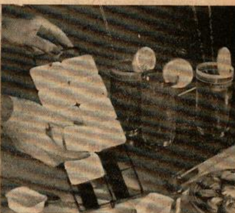
Un moule à glace en Ethocel, un plastique qui reste souple aux basses températures.
