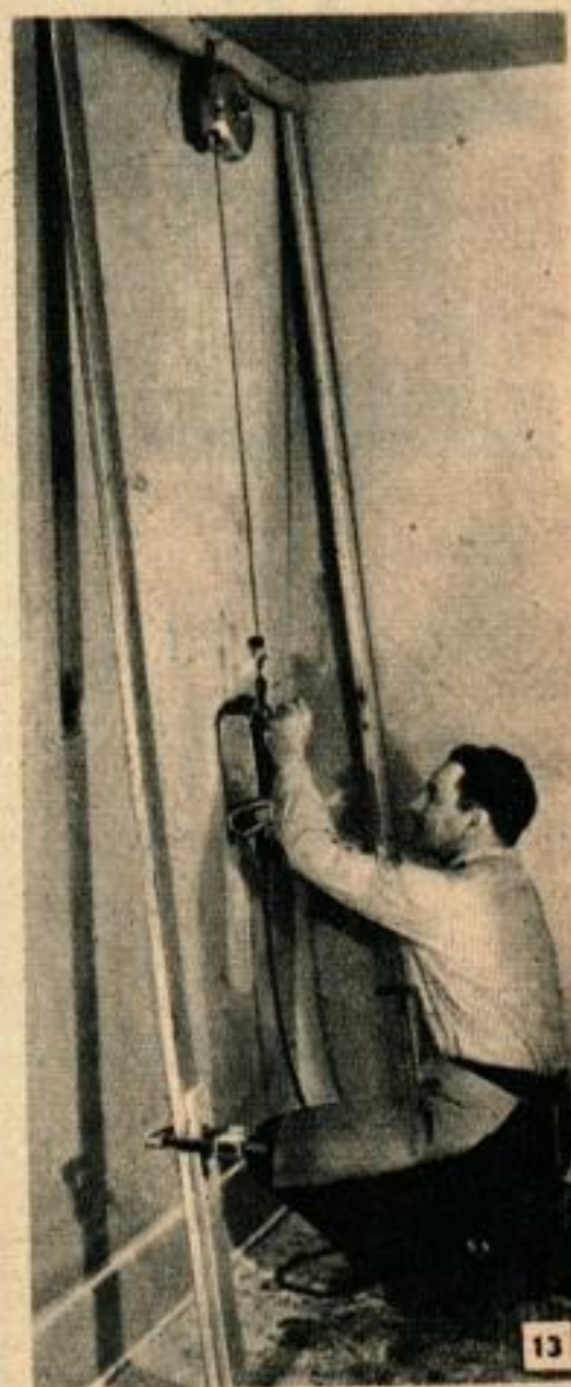
L'équilibrage facilite le travail de longue durée sur les surfaces verticales.
