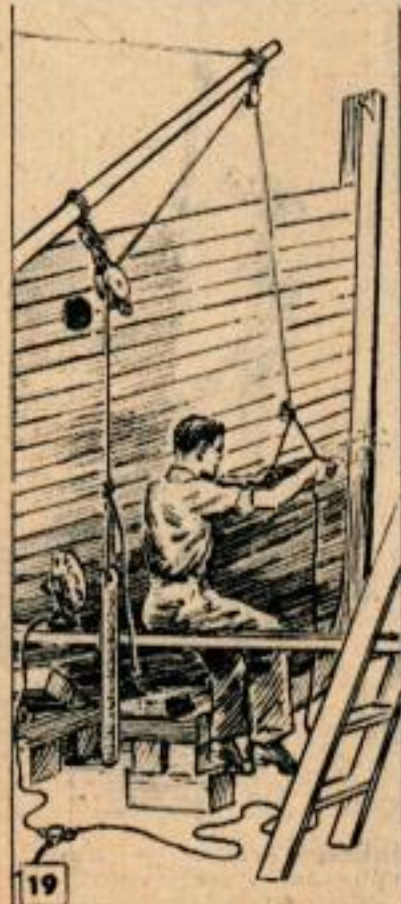
La bosse permet d'attaquer un point bien défini (joints entre des éléments).
