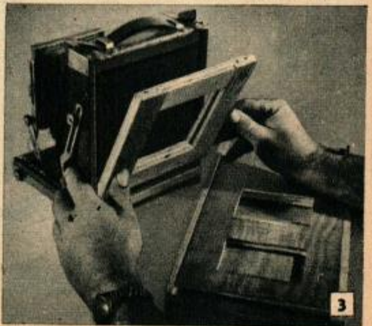
Ci-dessus, adaptateur en position pour prendre une vue horizontale. Le panneau porte-film ou porte-plaque a été déplacé dans la coulisse pour mettre le film devant la fenêtre de l'appareil. Ci-dessous, vérification de la mise en place correcte de l'adaptateur sur l'appareil photographique.
