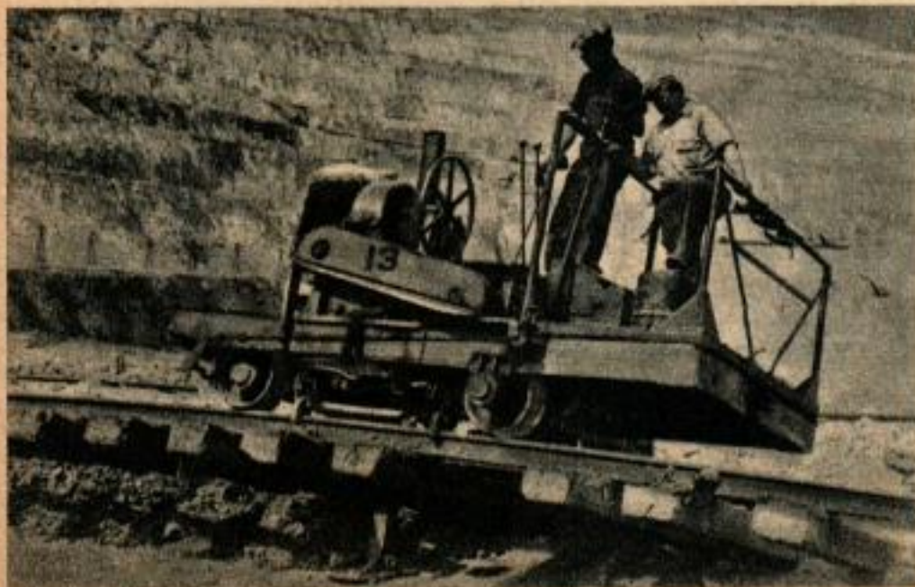
Cette machine déplace les rails au fur et à mesure que les parois sont absorbées.
