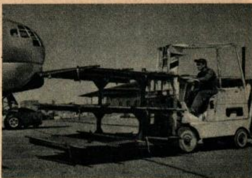
Un râtelier facilement maniable par un seul homme transporte 8 blessés. Le râtelier s'adapte au système élévateur de l'avion C-74 qu'on voit à l'arrière.
