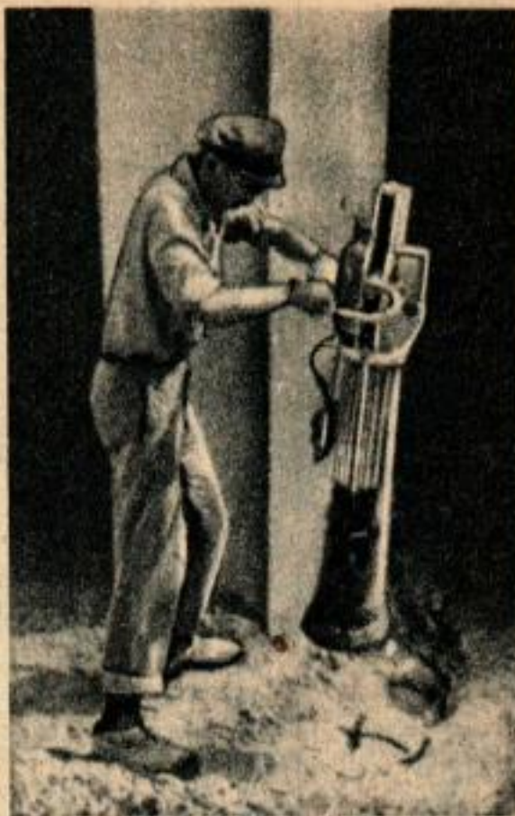
Dame ou tasseur spécial pour la terre et le remplissage de gravier représentée ici en action. Elle est actionnée par un piston coulissant dans un cylindre dans lequel un mélange combustible est enflammé par une étincelle de magnéto. Le coup de piston peut être utilisé pour faire remonter une dame de 30 à 50 cm. Elle retombe par son propre poids. Cet appareil est actionné par un homme et tasse 10 m 3 à 20 m 3 de terre par heure pour un litre de combustible, mélange formé d'essence et d'huile semblable à celui qui est utilisé dans les moteurs à deux temps.
