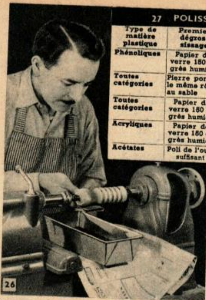
26 Le ponçage humide enlève les marques d'outil et polit la surface suffisamment pour préparer la finition.
