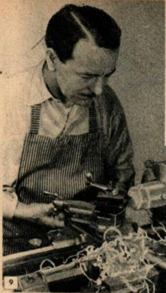
Les cordons et les hélices se font au moyen d'un outil de forme (fig. 10 et 12). Les pièces longues de plus de 10 cm sont tenues par une contrepointe à billes (fig. 10). Les pièces courtes sont serrées dans le mandrin à 3 mors.
