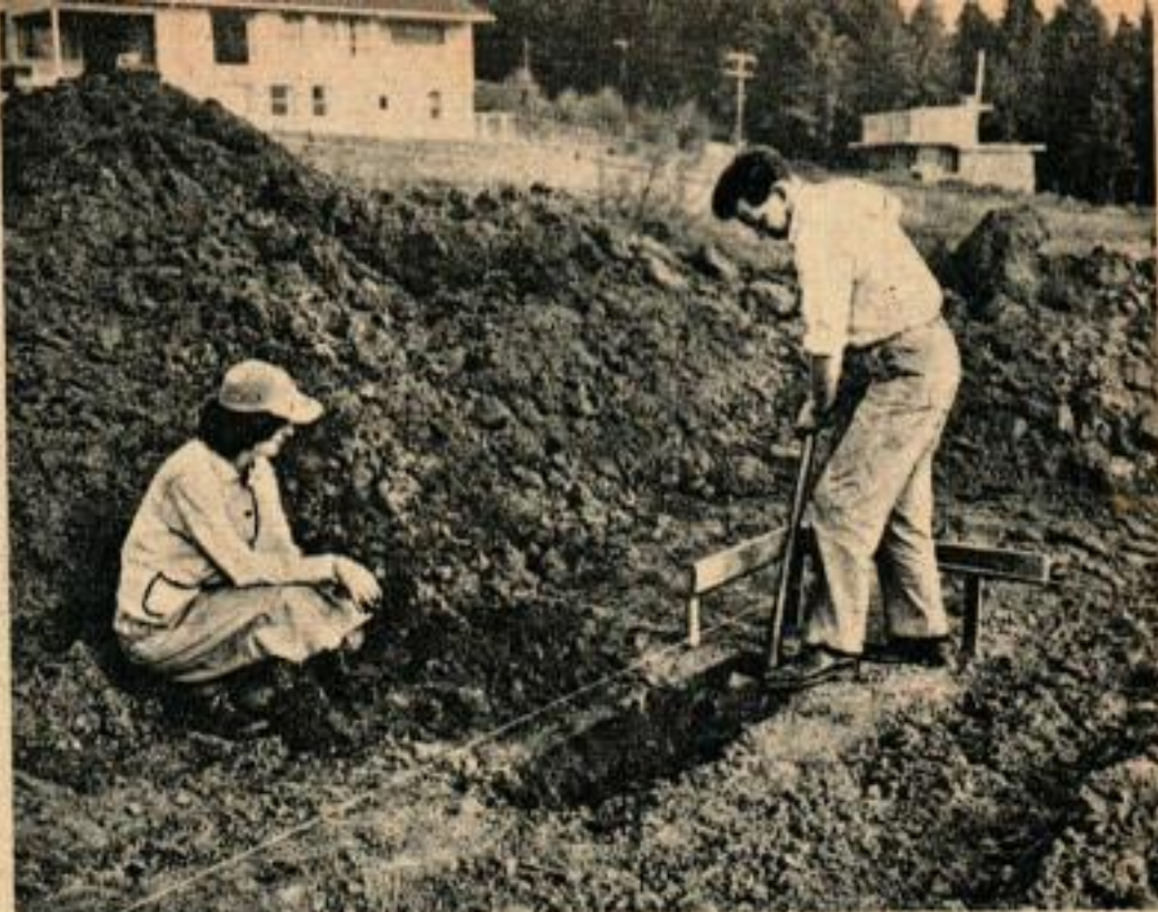
Après avoir creusé la première tranchée à la main, le reste de l'excavation a été achevé à la pelle mécanique.
