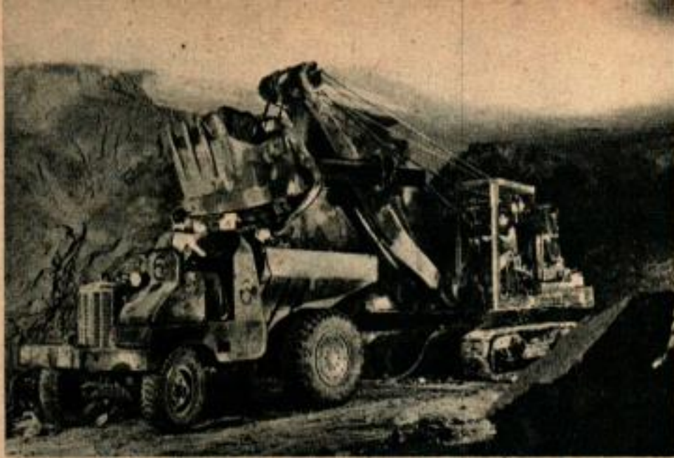
Les excavatrices électriques ont été démontées, descendues et remontées sur place.
