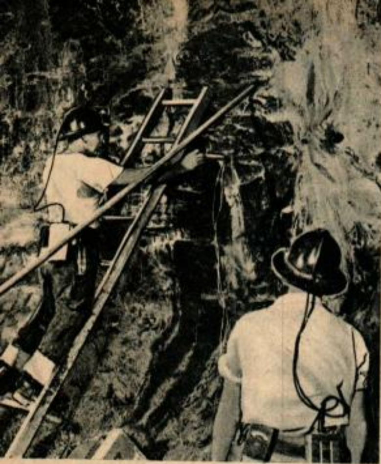
On place la dynamite dans les trous de mine. Le feu ne sera mis que lorsque tout le monde sera parti.
