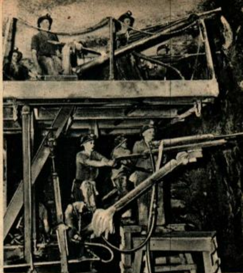
Les mineurs travaillent sur une charpente mobile et on les voit ici en train de pratiquer les trous de mine dans lesquels on enfonce les charges de dynamite qui feront tomber des blocs de craie de 15 m de côté. Dans un morceau de mur de 9 \times 10 m, on enlève près de 800 t lors de chaque explosion.
