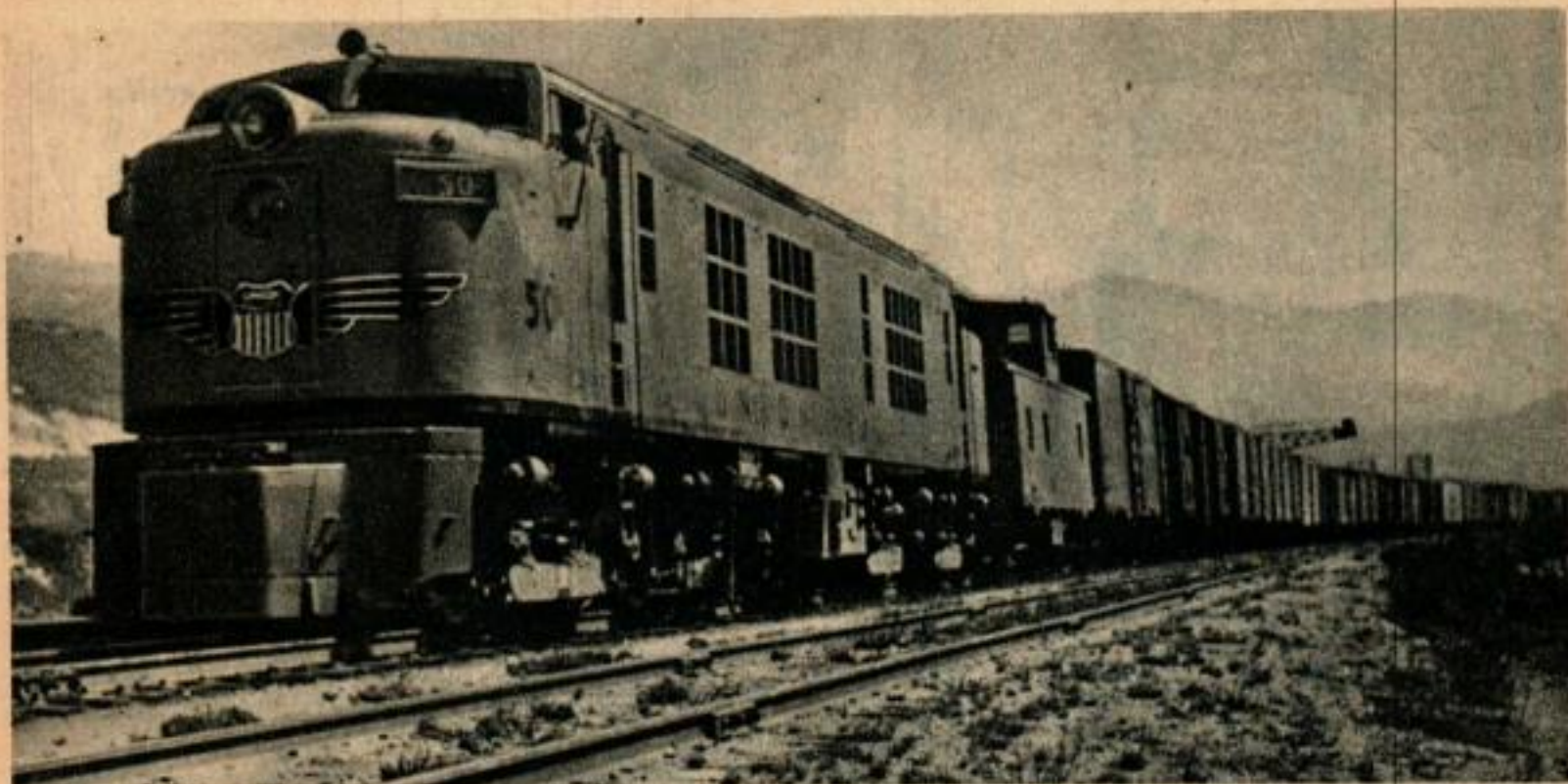
La locomotive X-50 a une puissance suffisante pour remorquer un train long de près de 1,5 km sur les pentes les plus dures de l'Union Pacific.
