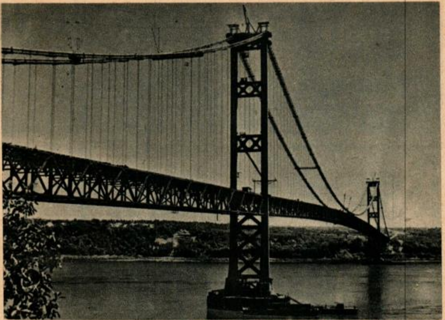
Le pont de Tacoma vers la fin des travaux. Il doit supporter une pression correspondant à un vent de 193 km/h. Ci-dessous, installation du fil servant de guide pour la pose du câble définitif de suspension.
