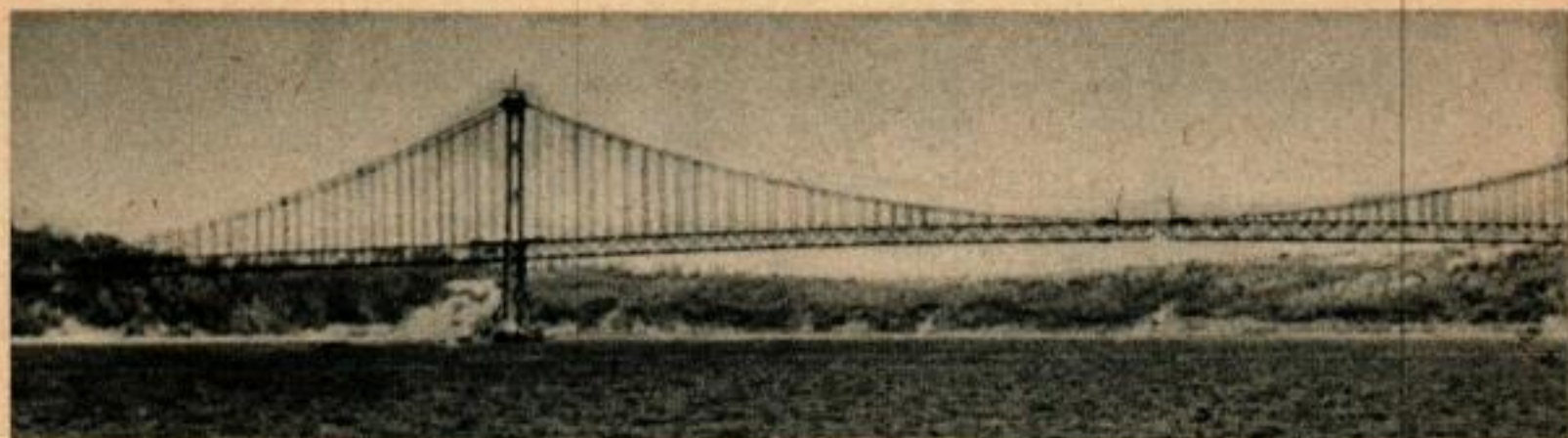
Le pont des Détroits est le troisième du monde par la portée, il a un tablier central de 855 m et deux tabliers extrêmes de 155 m.
