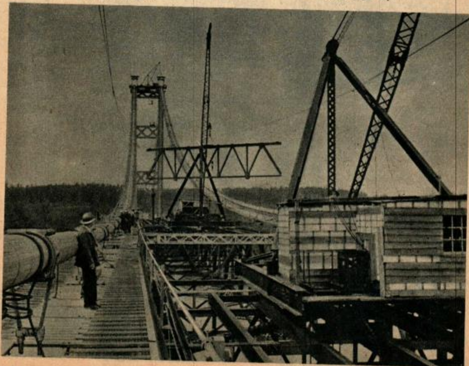
Après la pose des charpentes sur les piles, on met les câbles légers permettant l'installation des passerelles sur lesquelles les ouvriers se déplacent. Ci-dessous, une grue mobile est en train de poser un morceau de treillis du tablier de pont sous le regard attentif d'un des surveillants.
