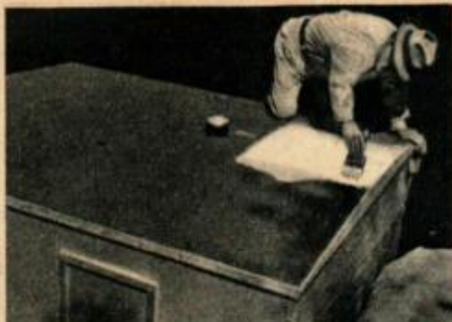
A gauche, l'extérieur du corps de la caisse est d'abord peint à l'aluminium, puis on termine par deux couches de peinture émaillée de la couleur désirée. À droite, mettre au sommet de chaque porte et fenêtre un petit linteau contre l'eau de pluie.
