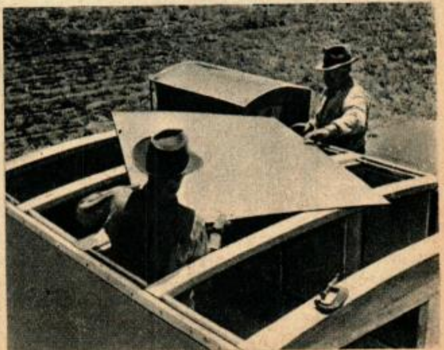
Ci-dessus, mise en place de la caisse, opération facilitée par l'emploi d'un tréteau. Ci-dessous, on a déjà posé les chevrons courbes afin de constituer un toit sur lequel glisse l'eau de pluie. Ces chevrons sont vissés sur les arceaux métalliques.
