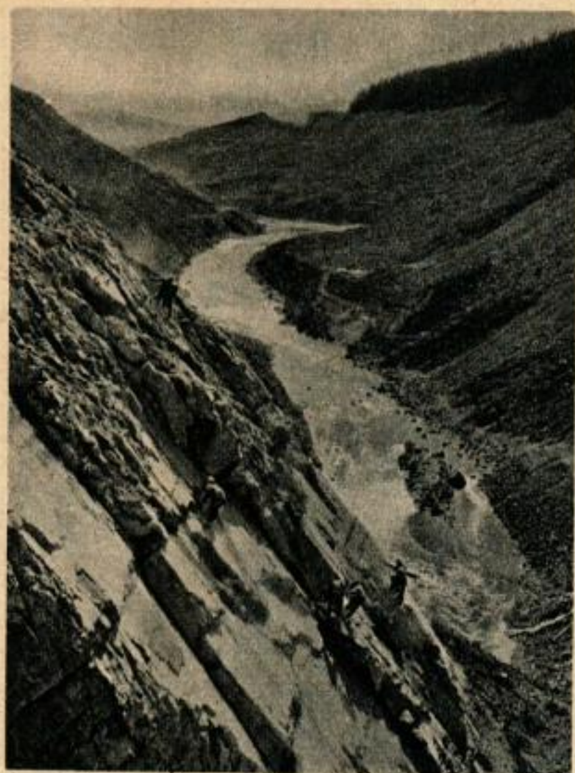
Les ouvriers liés par des cordes de sauvetage décapent la surface du ravin contre la paroi duquel s'appuiera l'un des côtés du barrage. Ci-dessous, vue générale de l'emplacement où se trouvera l'usine. On voit également les fondations en béton, la rivière, le talus en terre.
