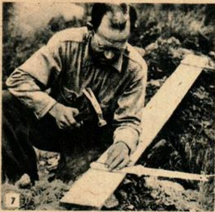
Une semelle en bois assez longue et munie de petits piquets est très utile, pour mettre en place correctement les tuyaux à l'inclinaison voulue.
