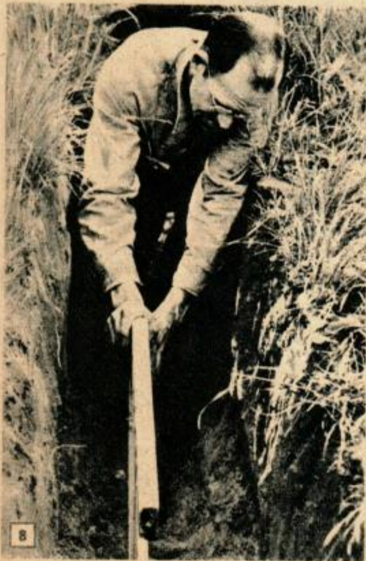
Une semelle en bois assez longue et munie de petits piquets est très utile, pour mettre en place correctement les tuyaux à l'inclinaison voulue.
