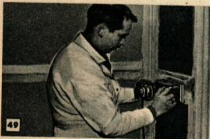
Les ponceuses oscillantes sont actionnées également par un moteur incorporé au bâti. Ici, on en utilise une pour poncer les raccords entre des panneaux de plâtre.
