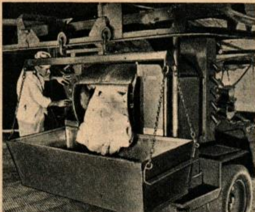
A gauche, la pâte malaxée est versée dans une auge de 225 kg. A droite, on pratique dans la masse en fermentation des canaux d'aération.
