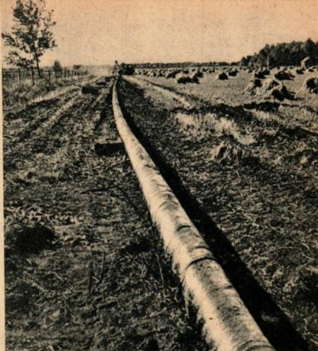
L'artère du pétrole, le pipe-line se construit dans trois dimensions, quarante, quarante-cinq et cinquante centimètres de diamètre. Ci-dessous, brûlage du pétrole mauvais, souillé de terre et de produits chimiques étrangers, lors la découverte d'un puits sur le terrain de Golden Spike.
