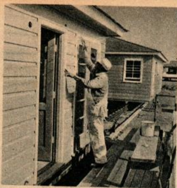
Vers la fin de la chaîne, la maison reçoit trois couches de peinture. L'acheteur choisit les teintes.
