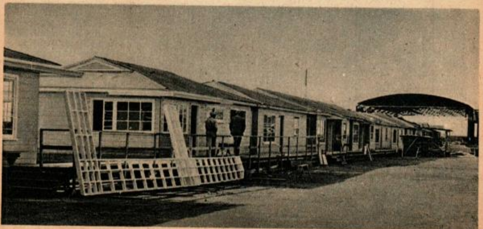
Reposant sur des rouleaux, treize maisons s'achèvent à la fois. — Ci-dessus, deux des cinq plans présentés à San Diego.
