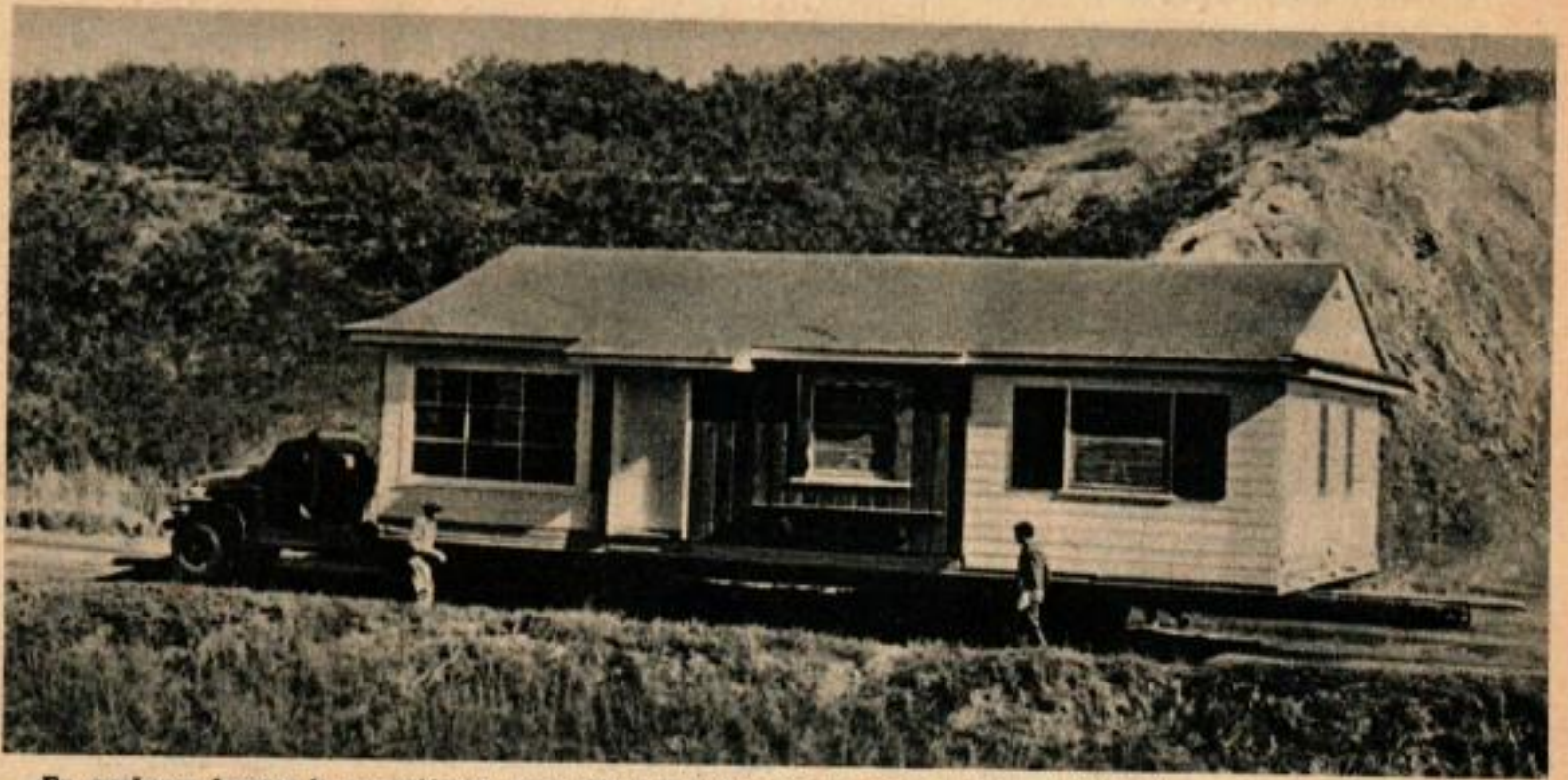
En quelques heures le propriétaire peut s'installer. Une des petites maisons fabriquées en usine roule sur une route vers son emplacement.
