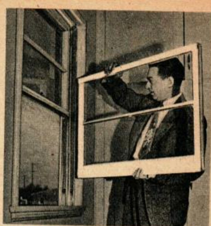
Parmi les caractéristiques nouvelles de ces maisons, il faut mentionner les fenêtres qui se retirent des châssis pour leur nettoyage.
