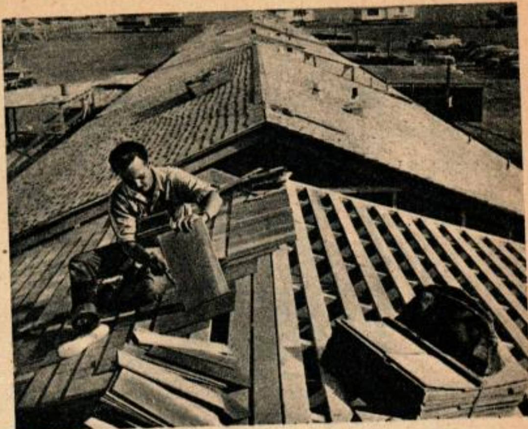
Les bardeaux sont cloués en place par un ouvrier spécialiste qui fait le même travail sur chaque maison à mesure qu'elle s'avance sur la chaîne. — Ci-dessous, les barres métalliques placées en diagonales, maintiennent les cloisons intérieures bien rigides.
