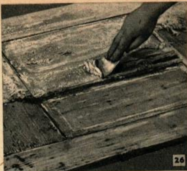
Cette vieille porte est en bien mauvais état. Les multiples couches de peinture dont elle est revêtue sont tout d'abord enlevées au moyen d'un liquide spécial de ramollissage et d'un racloir afin de mettre à nu le bois du panneau. Il est parfois nécessaire, sur de vieux objets de ce genre, de recommencer plusieurs fois l'opération.
