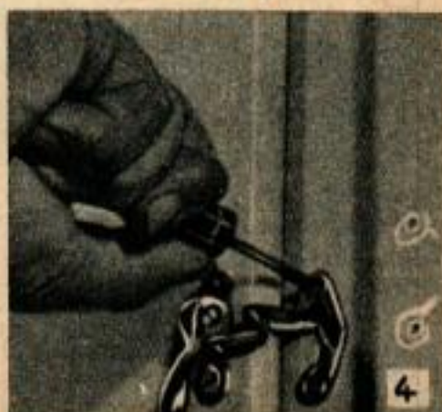
Enlever l'hubriserie des portes, fenêtres et placards.
