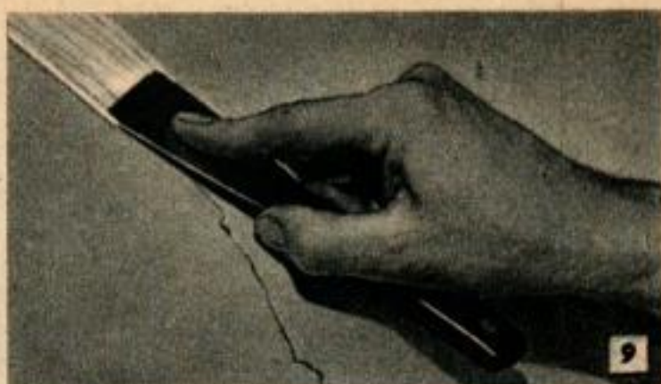
Remplir les fentes sur des surfaces plates avec un couteau à mastic.
