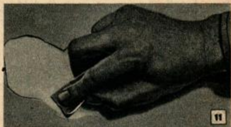
Ci-dessus, lisser le bord des vieilles couches de peinture. Ci-dessous boucher les pores produits dans le plâtre avec de la peinture.
