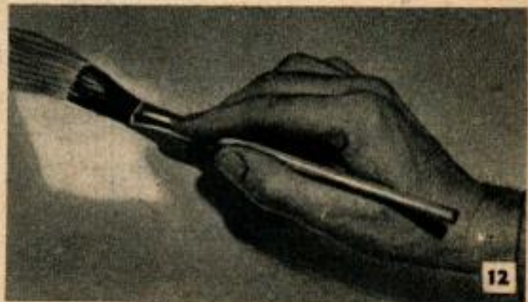
Ci-dessus, lisser le bord des vieilles couches de peinture. Ci-dessous boucher les pores produits dans le plâtre avec de la peinture.
