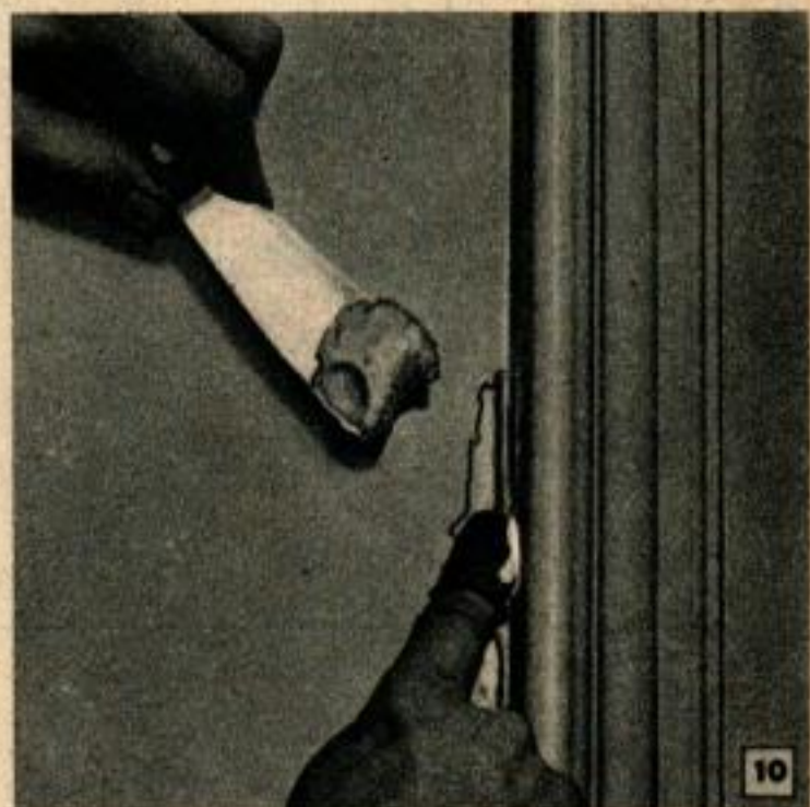
Dans les coins, on fait le remplissage avec un doigt de caoutchouc.
