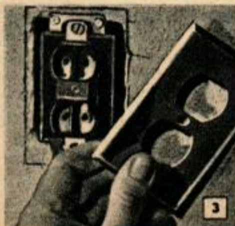
Les plaques de recouvrement des interrupteurs et prises de courants doivent être également enlevées.
