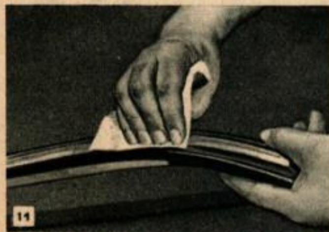
11 Le papier appuyé sur un feutre mince convient pour l'intérieur des moulures. Noter la position des doigts destinée à assurer la pression bien uniforme nécessaire pour un résultat régulier.
