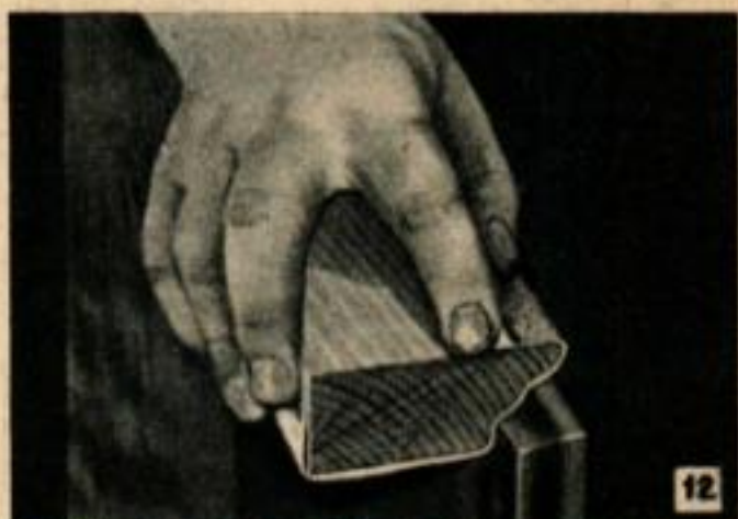
12 Un bloc abrasif sur lequel on a fait une contre-moulure permet le décapage complet de la vieille peinture ou du vieux vernis.
