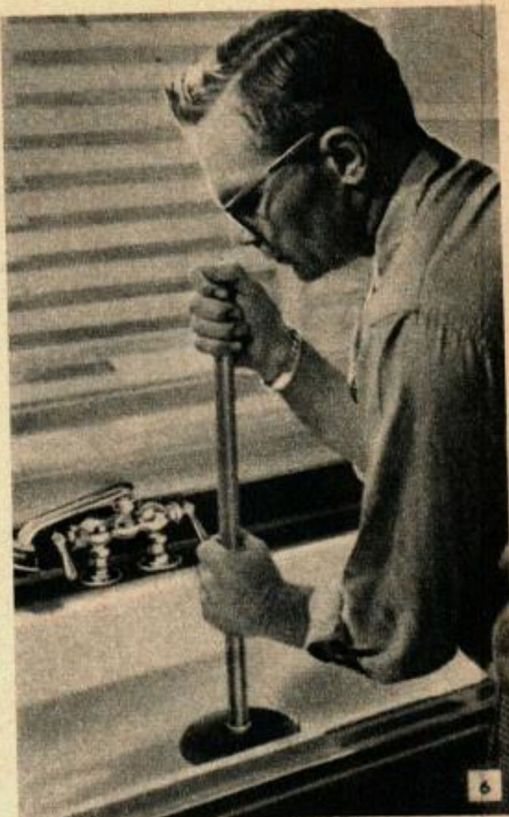
Un mouvement de va-et-vient avec une ventouse en caoutchouc suffit en général pour déboucher les éviers.
