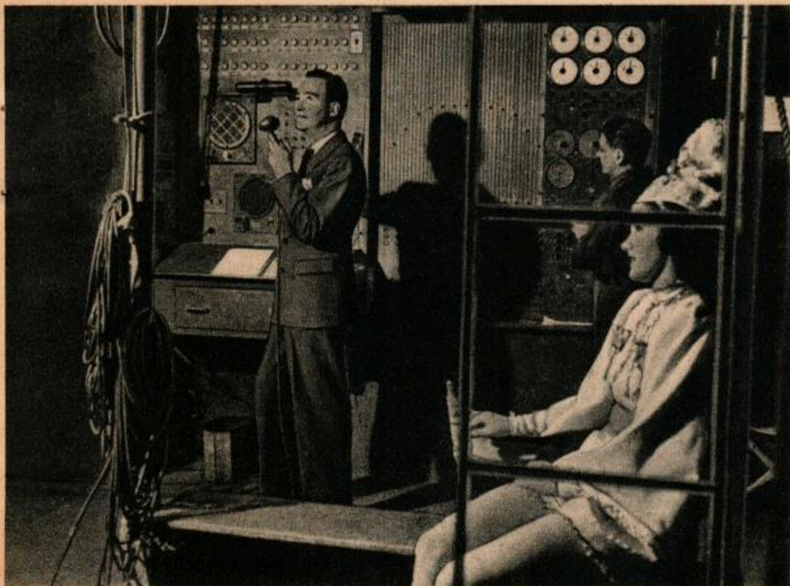
Le panneau central sur le tableau de commande du manager de scène règle le rideau géant; les boutons glissants représentent la situation préétablie.
