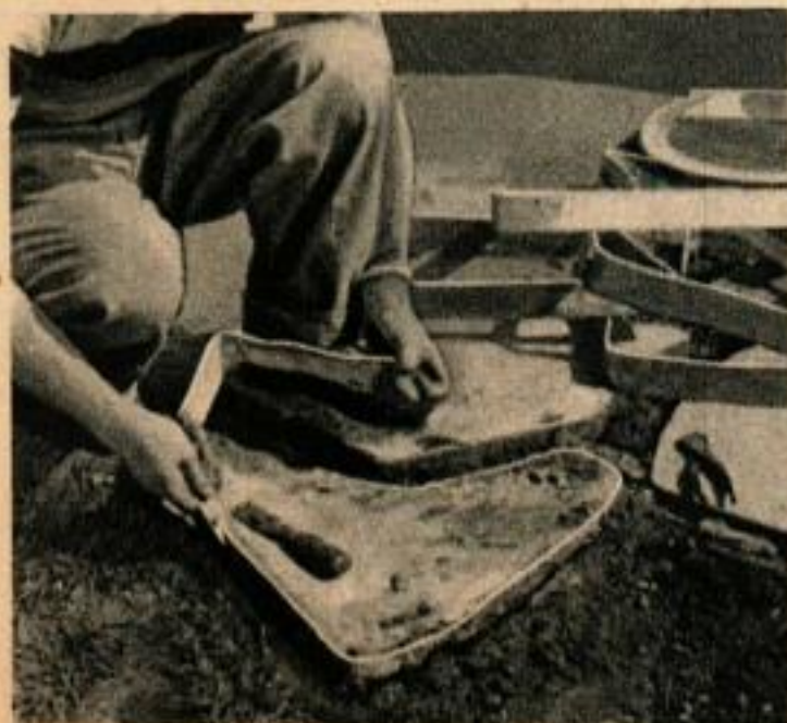
5. Il suffit de couper le fil de fer qui relie les extrémités des bandes de feuilard pour démouler les dalles.
