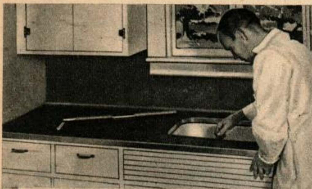
40 Traçage de l'ouverture de l'évier dans le linoléum.
