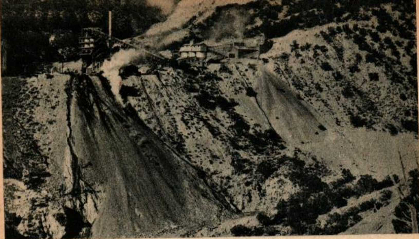
Le schiste perdu à l'usine expérimentale de Rifle (Colorado) est poussé dans un ravin à l'aide d'un bulldozer.
