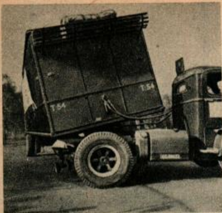
Il est parfois hasardeux de reculer avec une semi-remorque. Si la 5 e roue ne tourne pas, voilà le résultat.
